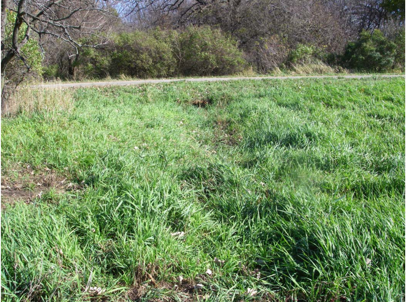
Photo 09. W-3 Culvert at Larson Rd.JPG
